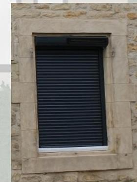
Type de Volet roulant intégré entre tableau et ne dépassant pas de la façade
