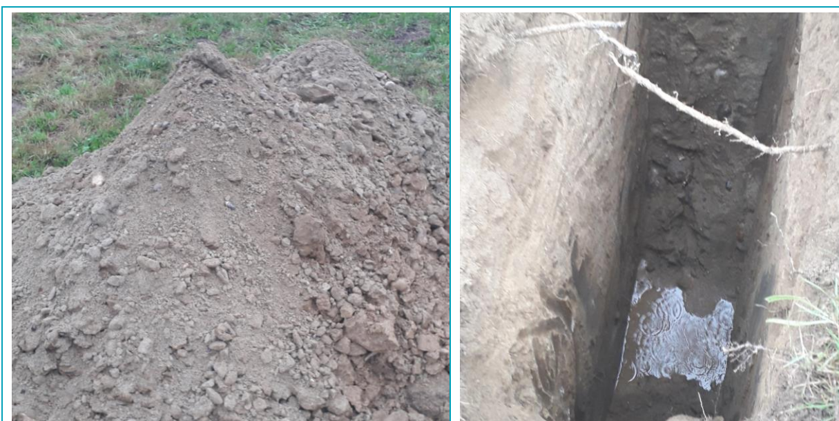
Sondage P1 (avec eau de l'essai d'infiltration).
