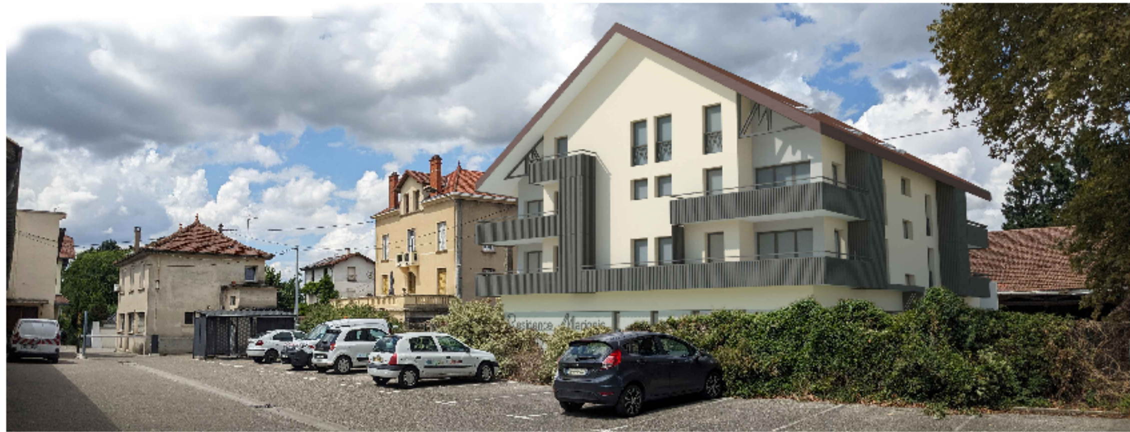
Vue 1 projet mis en situation
