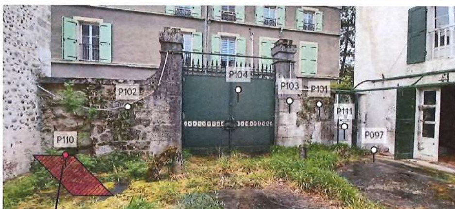
Conduit en fibres ciment (réseau enterré)
