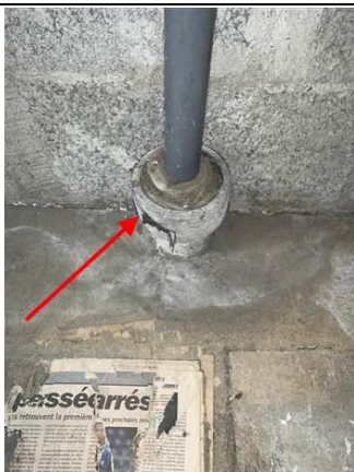
Photo n° PhA002 Localisation : Rez de chaussée - Chaufferie Ouvrage : Conduits de fluides (air, eau, autres fluides) Partie d'ouvrage : Conduits Description : Conduits Localisation sur croquis : ZPSO-002 Conduit amiante ciment
