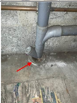
Photo n° PhA003 Localisation : Rez de chaussée - Chaufferie Ouvrage : Conduits de fluides (air, eau, autres fluides) Partie d'ouvrage : Conduits Description : Conduits Localisation sur croquis : ZPSO-003 Conduit amiante ciment
