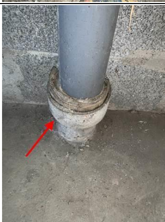
Photo n° PhA005 Localisation : Rez de chaussée - Garage 1 Ouvrage : Conduits de fluides (air, eau, autres fluides) Partie d'ouvrage : Conduits Description : Conduits Localisation sur croquis : ZPSO-005 Conduit en amiante ciment
