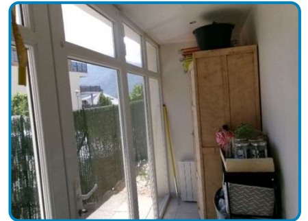
Rez de jardin Cage escalier
