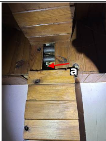
Photo n° PhA008 Localisation : Pièce 1 Ouvrage : 6 - Conduits et accessoires intérieurs - Conduits de fluides (air, eau, vapeur, fumée, échappement, autres fluides) Partie d'ouvrage : Conduit en fibres-ciment Description : Conduit en fibres-ciment Localisation sur croquis : M008
