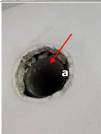
Photo n° PhA007 Localisation : Salle de bain Ouvrage : 6 - Conduits et accessoires intérieurs - Conduits de fluides (air, eau, vapeur, fumée, échappement, autres fluides) Partie d'ouvrage : Conduit en fibres-ciment Description : Conduit en fibres-ciment Localisation sur croquis : M007
