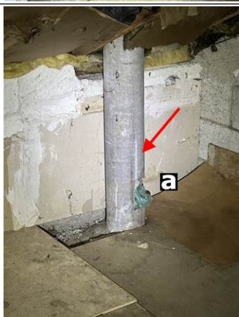
Photo n° PhA006 Localisation : Combles 1 Ouvrage : 6 - Conduits et accessoires intérieurs - Conduits de fluides (air, eau, vapeur, fumée, échappement, autres fluides) Partie d'ouvrage : Conduit en fibres-ciment Description : Conduit en fibres-ciment Localisation sur croquis : M006
