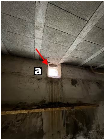
Photo n° PhA003 Localisation : Cave 3 Ouvrage : 6 - Conduits et accessoires intérieurs - Conduits de fluides (air, eau, vapeur, fumée, échappement, autres fluides) Partie d'ouvrage : Conduit en fibres-ciment Description : Conduit en fibres-ciment Localisation sur croquis : M003
