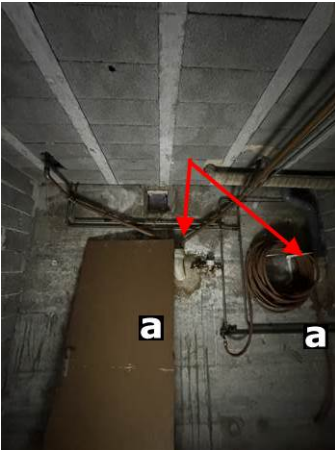
Photo n° PhA006 Localisation : Cave 1 Ouvrage : 6 - Conduits et accessoires intérieurs - Conduits de fluides (air, eau, vapeur, fumée, échappement, autres fluides) Partie d'ouvrage : Conduit en fibres-ciment Description : Conduit en fibres-ciment Localisation sur croquis : M006
