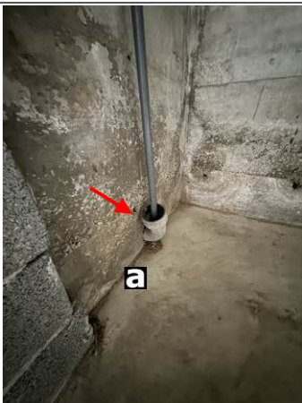
Photo n° PhA004 Localisation : Cave 2 Ouvrage : 6 - Conduits et accessoires intérieurs - Conduits de fluides (air, eau, vapeur, fumée, échappement, autres fluides) Partie d'ouvrage : Conduit en fibres-ciment Description : Conduit en fibres-ciment Localisation sur croquis : M004
