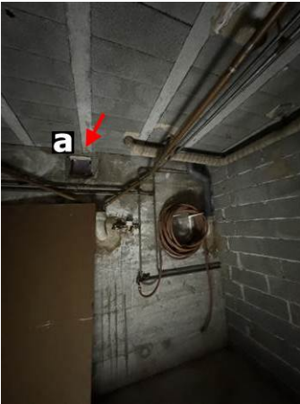
Photo n° PhA005 Localisation : Cave 1 Ouvrage : 6 - Conduits et accessoires intérieurs - Conduits de fluides (air, eau, vapeur, fumée, échappement, autres fluides) Partie d'ouvrage : Conduit en fibres-ciment Description : Conduit en fibres-ciment Localisation sur croquis : M005
